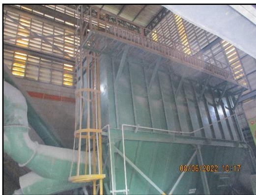
ภาพที่ 2.29 การติดตั้งเครื่องดักฝุ่นแบบถุงกรอง บริเวณเครื่องบดย่อยหิน
